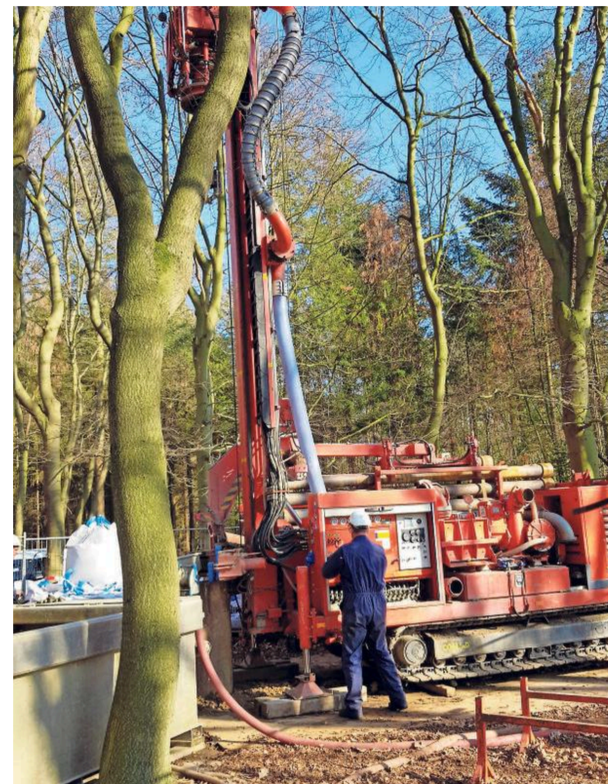
Een boorinstallatie in Hilversum.
